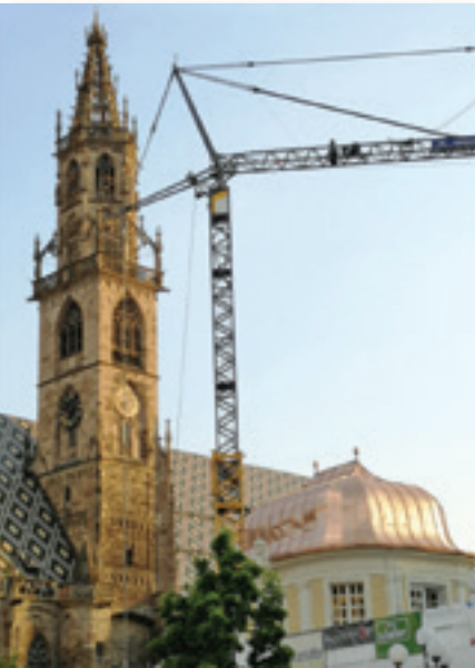
I lavori di ristrutturazione di Palais Campofranco, vicino al Duomo, in Piazza Walther. Das Palais Campofranco und der Dom am Waltherplatz Foto: Alberto Stenico
